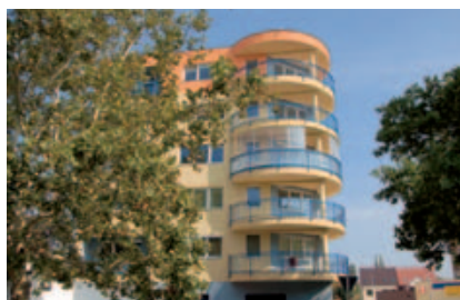
Pětipodlažní bytový dům ve Znojmě na nároží Pražské a Mičurinovy ulice vyzděný z pórobetonového systému YTONG v kombinaci se stěnami z vápenopískových kvádrů.
