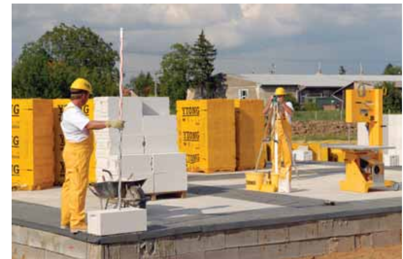
Specialisté ze společnosti Xella osobně přijedou ve sjednaný termín na vaši stavbu, kde bezplatně založí rohy první řady tvárnic na hotovou základovou desku
