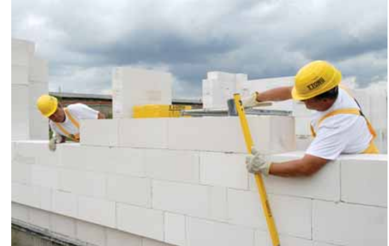
Přesné zdivo z tvárnic YTONG bez tepelných mostů se obejde bez zateplení
