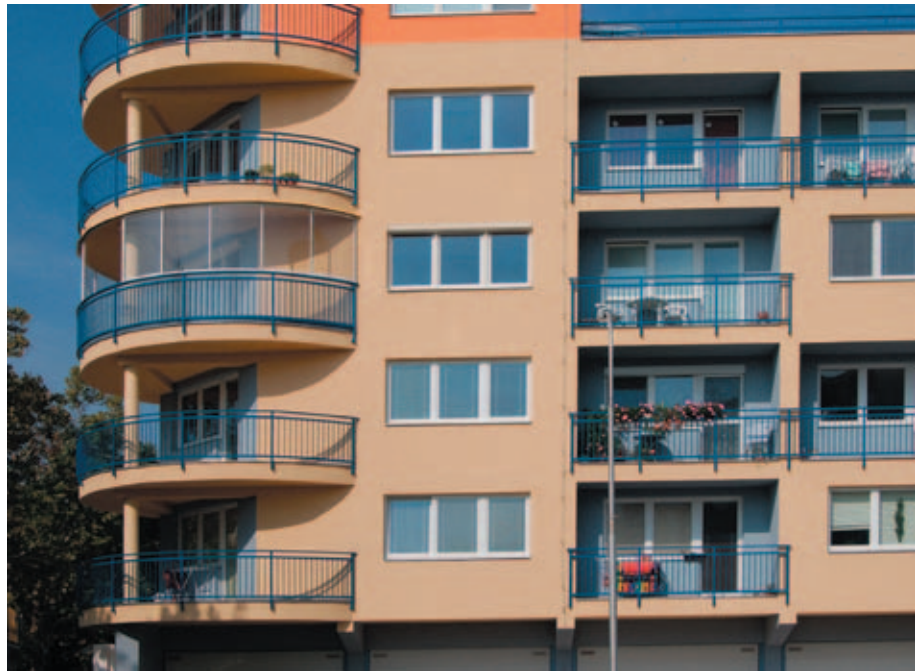
Bytový dům ve Znojmě (stěnový systém z pórobetonu)
