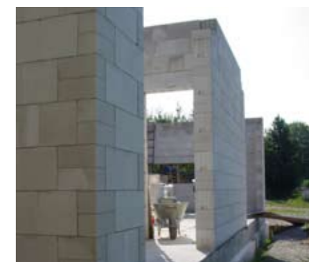
Pórobetonové tvárnice významně zjednodušují a usnadňují praktickou stavbu. Je ovšem zapotřebí využít veškerý potenciál, který zdicí tvárnice i celý stavební systém nabízejí
