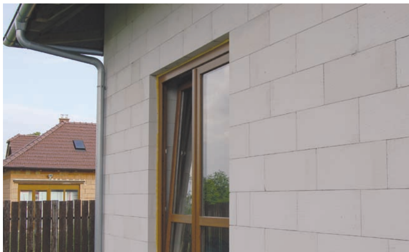
Snadné přesné řezání tvárnic a lepení na minimální maltové spáry jsou podmínkou přesného zdění bez tepelných mostů.
