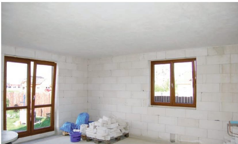
Přesné stěny snižují spotřebu omítkovin a zrychlují omítání. Pečlivost se tedy vyplatí také finančně.
