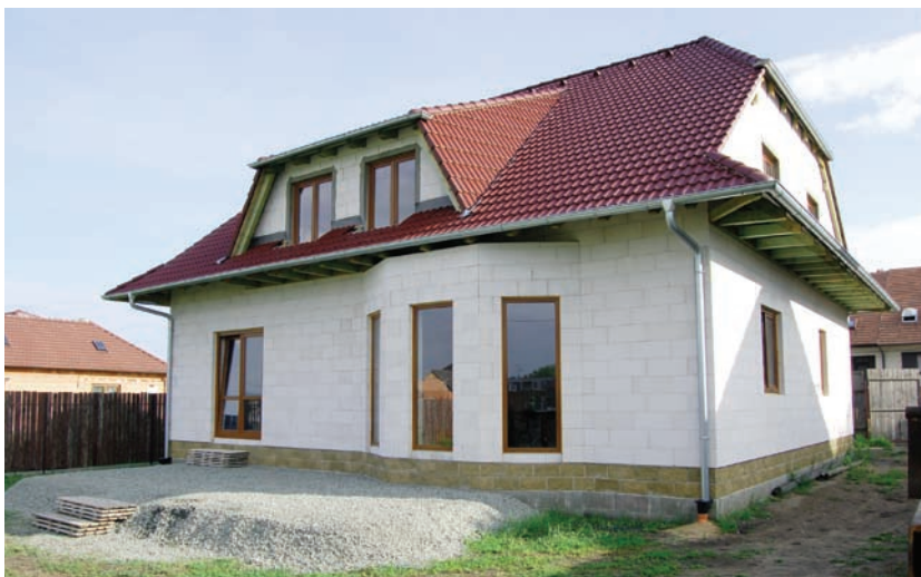
Místo uložení stropů a pozední věnec není na fasádě domu patrné. Celý detail je pečlivě proveden nejen na pohled, ale hlavně z hlediska tepelných mostů.
