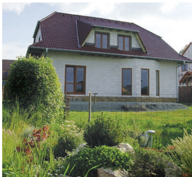
Zdivo domu je vyskládáno z tvárnic tak přesně, že z odstupů několika metrů dům vypadá jako omítnutý bílým štukem a spáry mezi zdicími prvky jsou téměř neznatelné.
