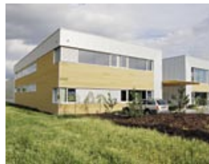
V letošním roce dokončila společnost DK1 stavbu svého nového sídla v Kravařích. Železobetonový skelet vyplňuje pórobetonové zdivo YTONG, které je receptem společnosti DK1 na kvalitní a rychlou stavbu.
