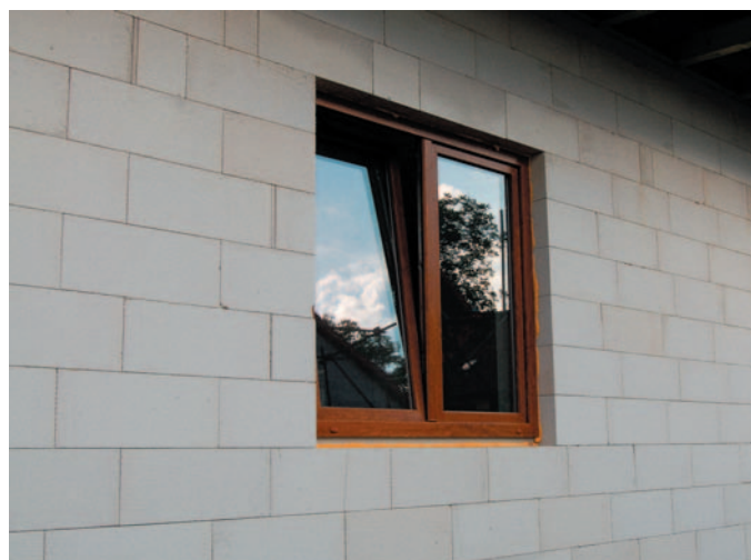
Tepelné ztráty u staveb z pórobetonu eliminuje přesné zdění na minimální spáry
