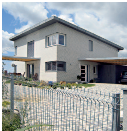
Velkou předností pórobetonových rodinných domů jsou kromě rychlé výstavby, optimální parametry vnitřního klimatu. RD z produkce DK1.
