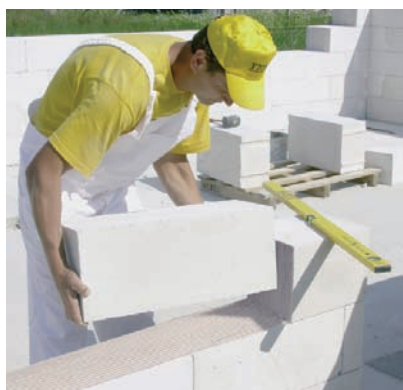
Chytré a rychlé stavební technologie budou udávat takt budoucímu stavebnictví [1]
