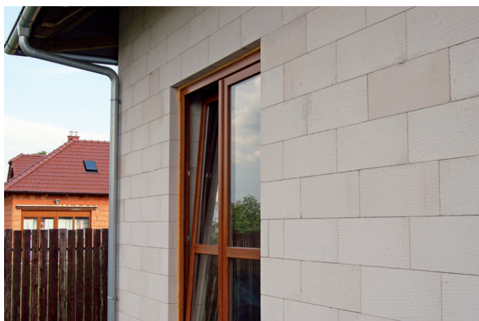
Snadné a přesné řezání tvárníc a lepení na minimální maltové spáry jsou podmínkou přesného zdění bez tepelných mostů.
