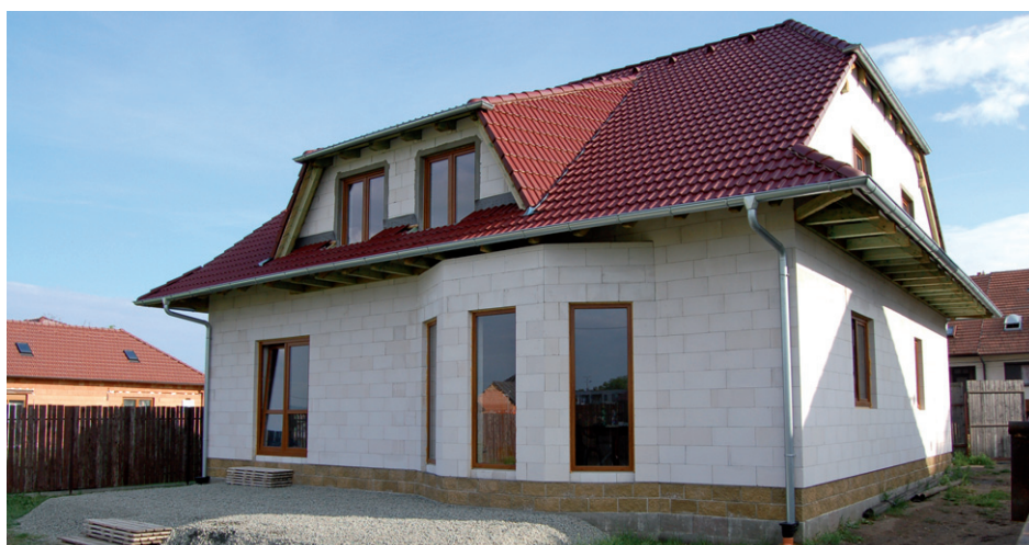
Místo uložení stropů a pozední věnec není na fasádě domu patrné. Celý detail je pečlivě proveden nejen na pohled ale hlavně z hlediska tepelných mostů.
