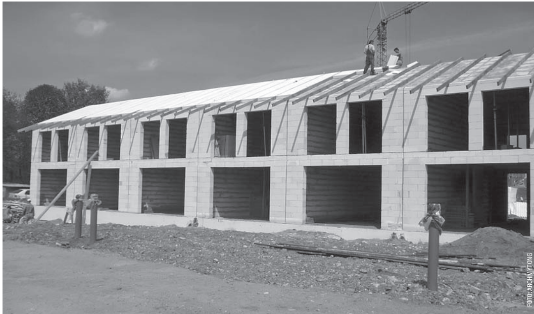
Výstavba pasivních domů Ytong v Židlochovicích na Moravě.
