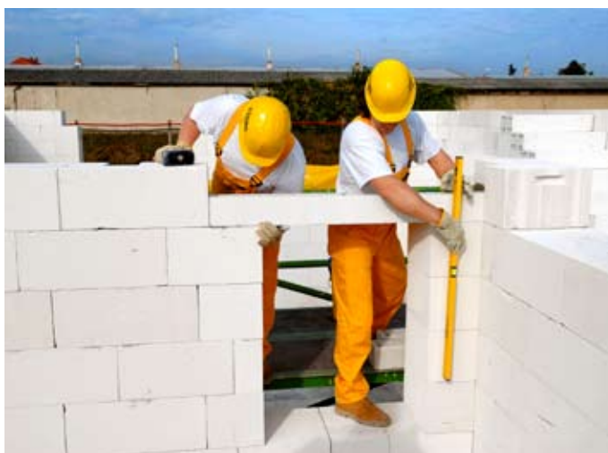
Podmínkou energetických úspor je přesné zdění bez tepelných mostů
