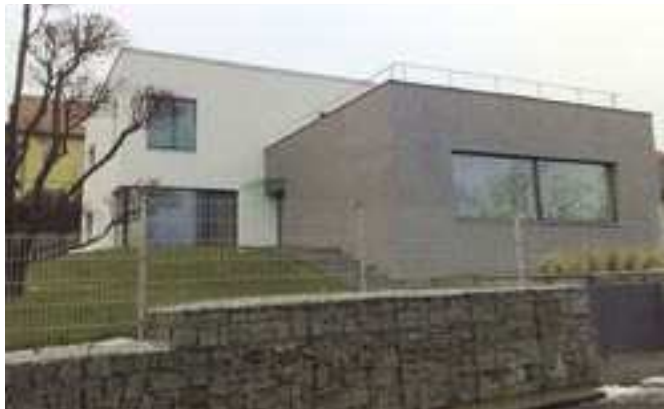
Pasivní domy přinášejí poněkud jinou koncepci domu a bez pečlivé osvěty mohou být lidem velmi vzdálené. Pasivní dům z pórobetonu Ytong v Plzni slouží jako předváděcí a školící centrum pro širokou veřejnost.
