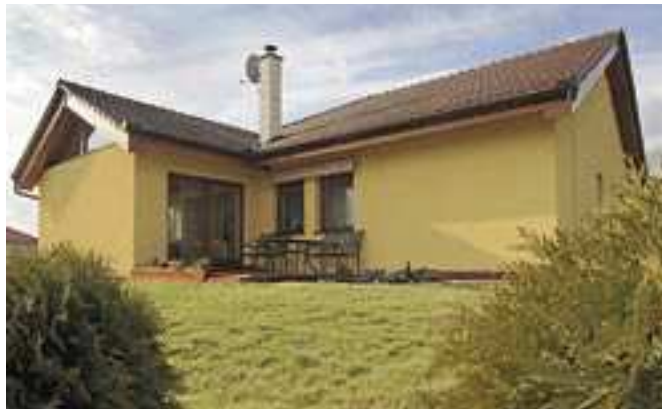
Nízkoenergetické domy se pomalu stávají masovou záležitostí a jejich podoba se blíží domům konvenčním. Nízkoenergetický dům v Černé hoře vděčí za svůj úsporný režim obvodovým stěnám Ytong Lambda tloušťky 500 mm bez zateplení.
