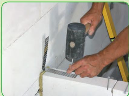
**2)** Polohu příčky si vyznačte na nosné stěně a dbejte na svislost. Boční stěnu je vhodné odizolovat proužkem minerální vlny, nebo spáru po vyzdění vyplnit montážní pěnou. Proti pohybu a odtržení je třeba
