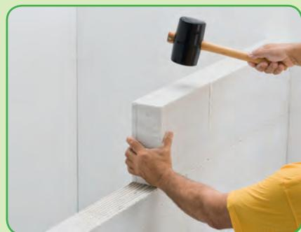
**3)** Každou další řadu tvárnic lepte na minimální tloušťku maltové spáry (1–3 mm). Dbejte na nanesení malty po celé šířce zdiva zubatou lžící odpovídající šířce. Příčkové tvárnice nemají pero a drážku, proto je nutné lepit i svislé spáry. Kvůli lepšemu usazení tvárnic mějte po ruce gumové kladívko. Průběžně kontrolujte svislost příčky.
