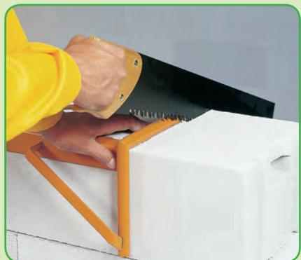
**5)** V kladení vrstev tvárnic můžete pokračovat dál až do stropu nebo plánované výšky příčky. Příčku nemusíte ke stropu klínovat, stačí použít spojku zdiva nebo montážní pěnu. Díky své štíhlosti zabere příčky jen minimum cenné bytové plochy (k dispozici jsou tvárnice pro obezdívky tloušťky 50 a 75 mm nebo příčkovky tloušťky 100, 125 a 150 mm). Důsledné oddilatování příčky od stropu a nosných stěn vás uchrání od budoucího praskání příčky, způsobeného statickým namáháním stavby.
