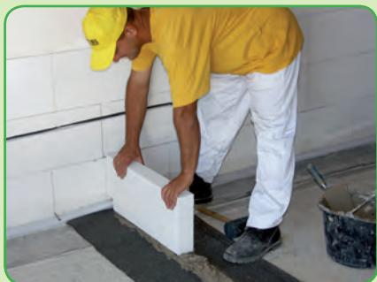
**1)** Budoucí místo zdění podložte živčinou izolací a začněte s přípravou maltového lože z vápenocementové malty. Dbejte především na vodorovnost i svislost každé tvárnice a přesné napojení prvků s minimální spárou. Tu vyplňte vždy předepsanou zdicí maltou Ytong. Po založení nechte první řadu vyzrát do dalšího dne.
