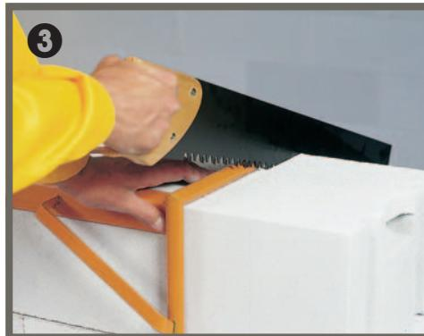
Snadné řezání a opracovatelnost pórobetonu umožňuje dokonalé vyzdění ve stísněných prostorech kolem vany a není tak potřeba objednávat různé speciální tvarovky a rozměrové varianty. Na řezání tvárnic je vhodná ruční pila na pórobeton nebo stačí obyčejná pilka na dřevo. Dochází tak k minimálnímu odpadu materiálu na stavbě, což představuje další časové i finanční úspory.
