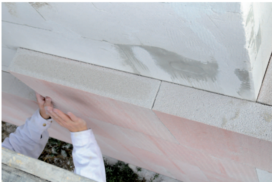
Obr. 5 Upevňování ekologických desek Multipor
