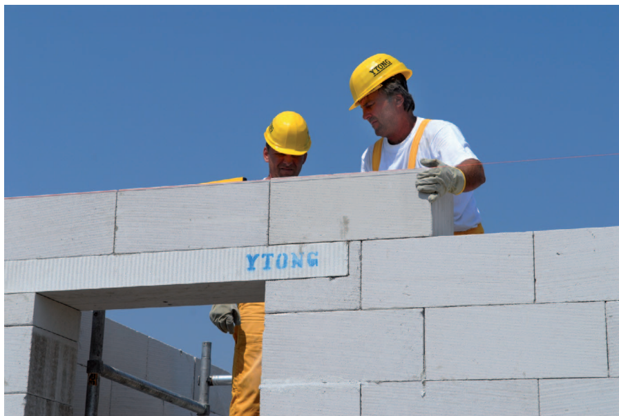
Obr. 2 Zdění s pórobetonovými tvárnici
