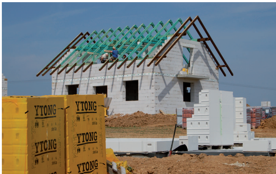
Obr. 6 Výstavba domu systémem YTONG
