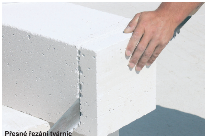
Přesné řezání tvárníc
