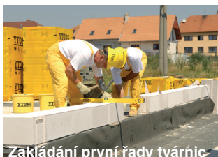
Zakládání první řady tvárnic
