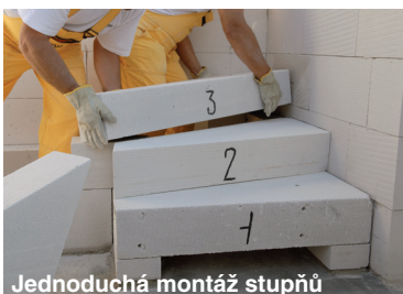
Jednoduchá montáž stupňů
