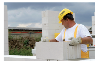
Tvárnice s perem a drážkou
