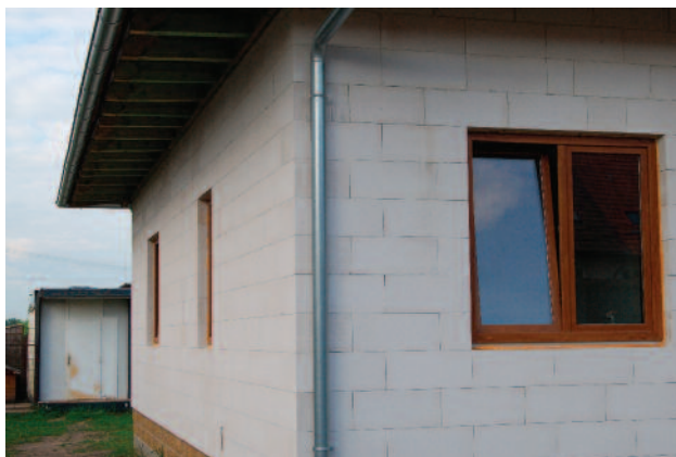
Z pórobetonu lze snadno vyzdít na milimetry přesný obvodový plášť. Dokazuje to i rodinný dům v Nýřsku, který byl postaven svépomocnou cestou.
