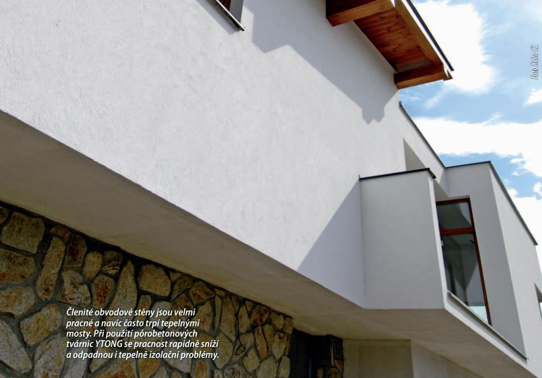
Členité obvodové stěny jsou velmi pracné a navíc často trpí tepelnými mosty. Při použití pórobetonových tvárníc YTONG se pracnost rapidně sníží a odpadnou i tepelné izolační problémy.
