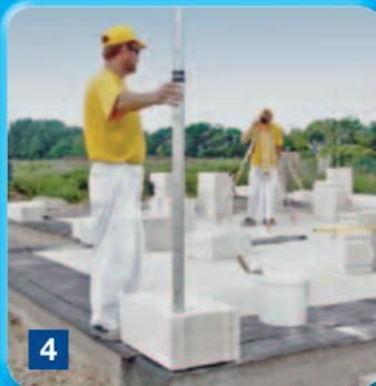
Na základový pás nebo základovou desku naneste po očištění penetrační nátěr a natavte hydroizolaci šířky min. 500 mm. Vyměřte přesné rozměry půdorysu a polohu budoucích obvodových stěn dle projektu. Jako první usadte tvárnici v nejvyšším rohu základové desky, pery k vnějšímu lící. Tvárnice ukládejte na vápenocementovou maltu celou první řadu tvárnic. Dbejte na vodorovnost ve všech směrech, zejména v napojení stěn. Případné nerovnosti zarovnejte hoblikem.
