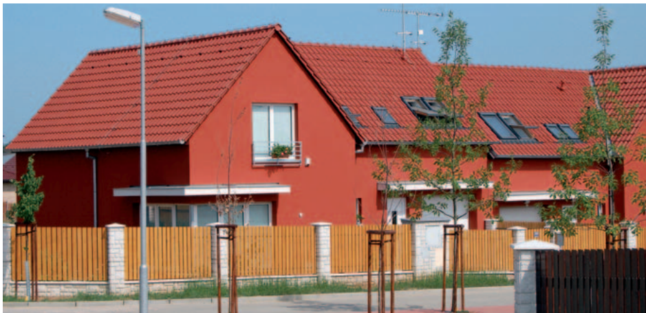
Kvalitní a přesná výstavba je nejlepší reklamou každé firmy (řadové domy v Dolních Břežanech od společnosti Staving Olomouc)
