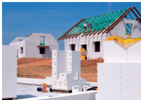
Přesná hrubá stavba z pórobetonu YTONG je zárukou vysokého komfortu bydlení.
