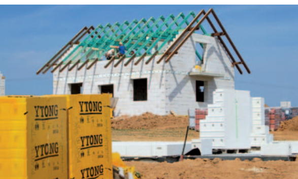
Přesná hrubá stavba z pórobetonu YTONG je zárukou vysokého komfortu bydlení (foto Staving Olomouc, lokalita Psáry a Dolní Břežany).
