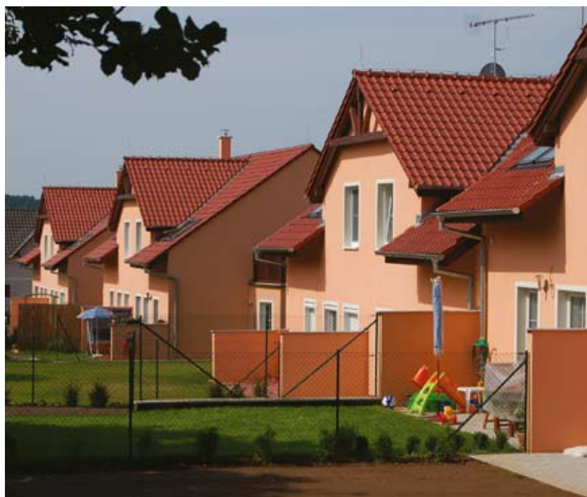
Řadové rodinné domy v Dolních Břežanech (realizace Staving Olomouc)
