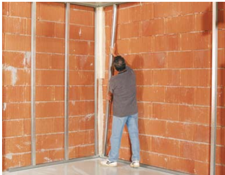
Předsazená stěna RIGIPS může zlepšit zvukový útlum až o 12 dB. Účinnost však závisí na mnoha činitelích, které správně posoudí jen zkušený odborník (materiál, plošná hmotnost a celková zvuková izolace stávající stěny, vliv okolních konstrukcí a detail vzájemného napojení)
