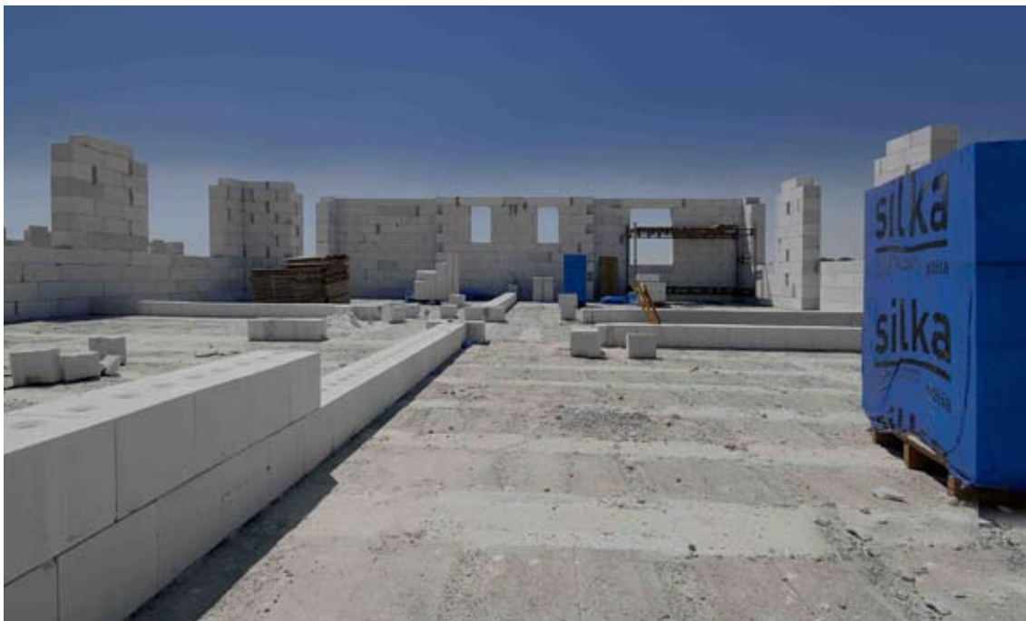
Řešením pro akustické a nosné stěny je výstavba z vápenopískových tvárnic SILKA: stěna tloušťky 250 mm bez omítky dosahuje hodnoty vážené vzduchové neprůzvučnosti R_w = 54,6 dB (SILKA S20-2000, cena 872,50 Kč/m 2 bez DPH, XELLA CZ)
