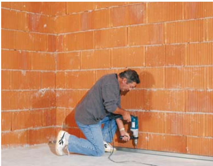
Pokud zjistíte, že stávající stěny nevyhovují požadavkům na zvukovou izolaci, situace má poměrně jednoduché řešení: vytvoření předsazených stěn z minerální izolace obložené sádrokartonem (RIGIPS). Ty se montují rychle a jednoduše do kovové konstrukce uchycené v podlaze i ve stropě
