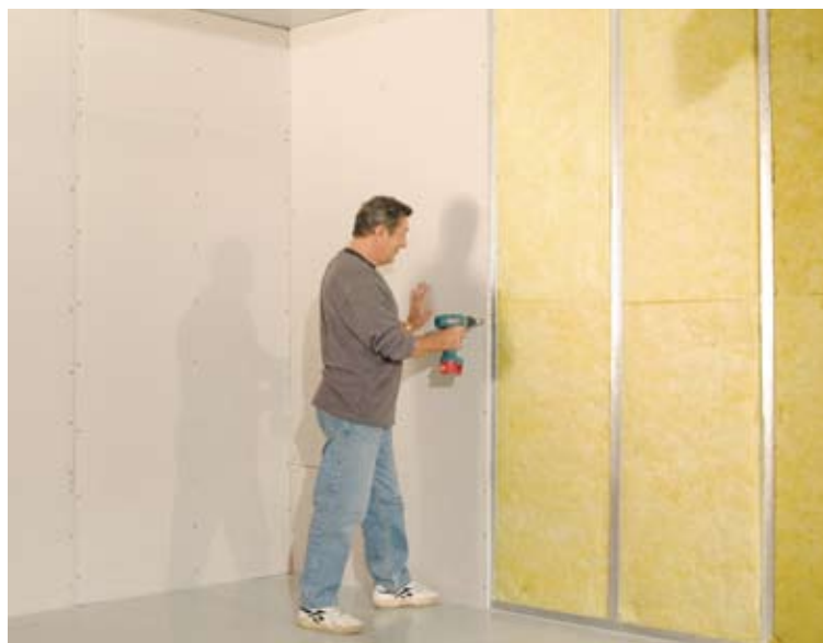
Finální úprava předstěny: na kovový rošt s minerální izolací Isover Piano tloušťky 60 mm se montují sádrokartonové desky Rigips RB tloušťky 12,5 mm
