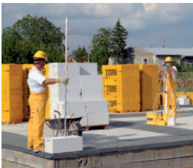
Bezplatná služba výrobce – přesné založení rohů zdiva
