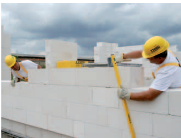
Přesné zdivo z tvárnic YTONG bez tepelných mostů se obejde bez zateplení
