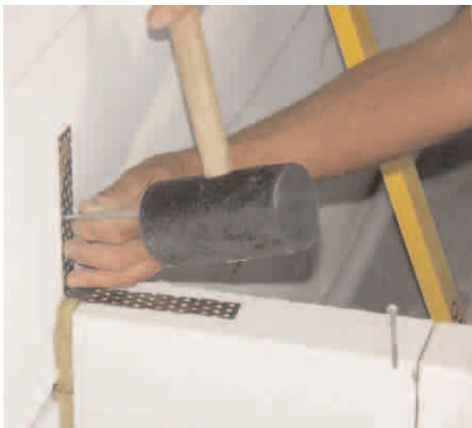
Příčky kotvíme pomocí nerezových spojek zdiva. Spojky upevníme do zdiva nerezovými hřebíky, nebo je můžeme vmáchnout do maltového lože
