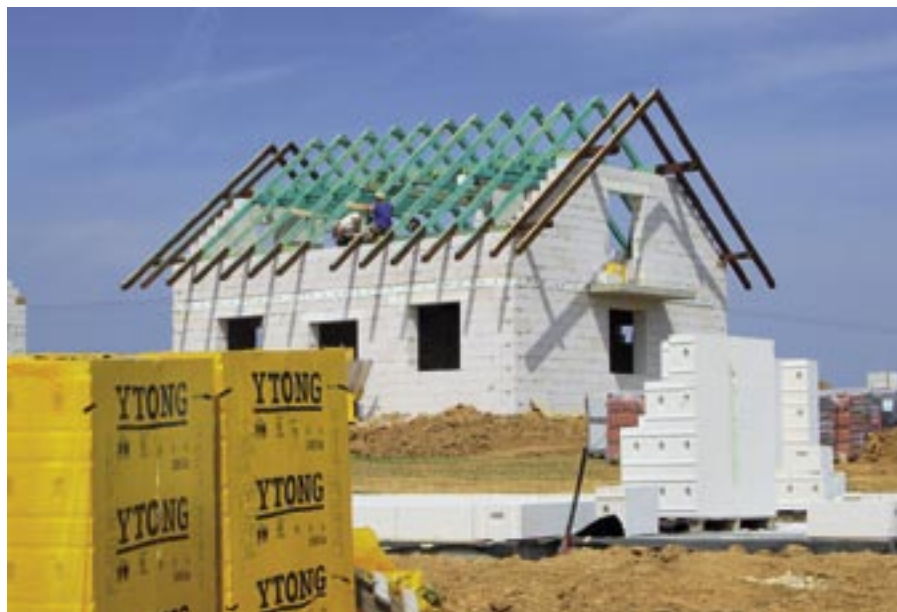
Precizní hrubá stavba je podmínkou kvalitní stavby (rezidenční výstavba v Psárech u Prahy (Staving Olomouc))
