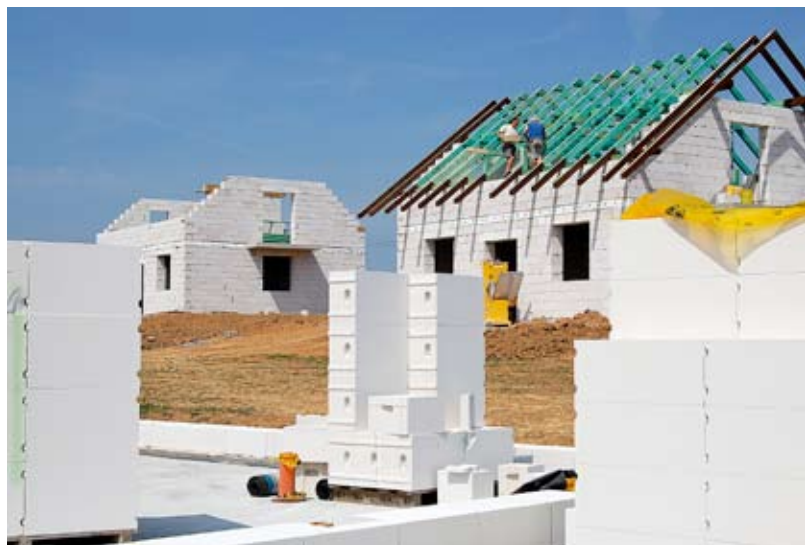
Přesná hrubá stavba z pórobetonu YTONG je zárukou vysokého komfortu bydlení.
