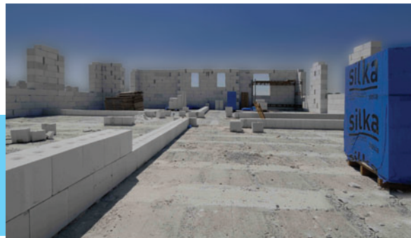
Čistá a rychlá stavba, přesné lepení na tenkovrstvou maltu. Technologie zdění stěn SILKA je stejná jako u stavebního systému YTONG.
