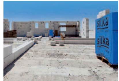
Vlastnosti materiálu dovolují optimální využití i pro nosné vnitřní stěny vícepodlažních budov
