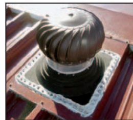
Ventilační turbína s prostupovou manžetou Dekтите
