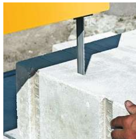
Tvárnice se velmi snadno řeže do požadovaných tvarů ruční nebo elektrickou pilou
