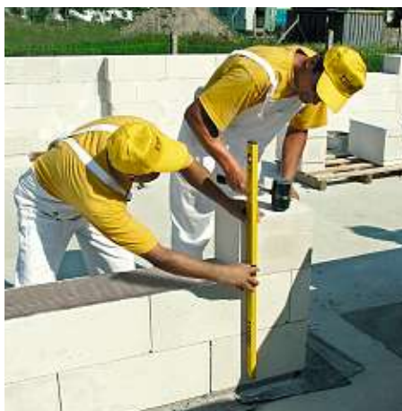
Při stavbě nosné zdi z pórobetonových tvárnic ušetří čas přesná práce
