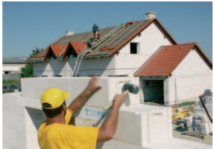
Obvodové stěny YTONG LAMBDA tloušťky 37,5 cm mají i bez omítky stejnou tepelnou izolaci jako keramické stěny s deseti centimetry polystyrenu. Vysoká prodyšnost pórobetonu navíc umožňuje stavbě dýchat a zajišťuje také optimální vlhkostní klima v interiéru.
