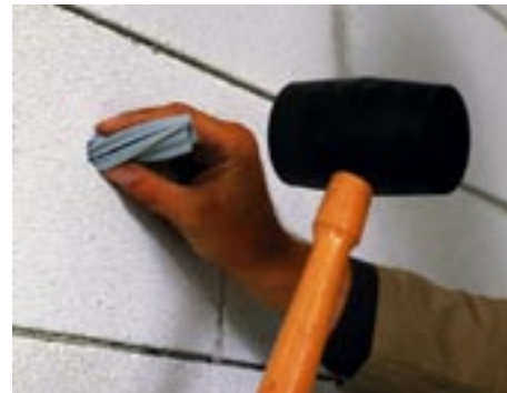
Speciální hmoždinky do pórobetonu kamkoliv v koupelně osadí i laik, přitom unesou předměty o velké hmotnosti.
