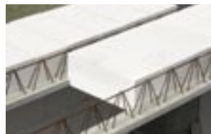
Jednoduchá montáž bílého stropu YTONG zvyšuje produktivitu práce na stavbě a umožňuje kvalitní realizaci i svépomocí.
