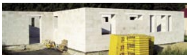
YTONG LAMBDA tloušťky 375 mm – tepelný standard nízkoenergetického domu, vynikající požární odolnost, přitom levnější a rychlejší než běžné obvodové stěny.
