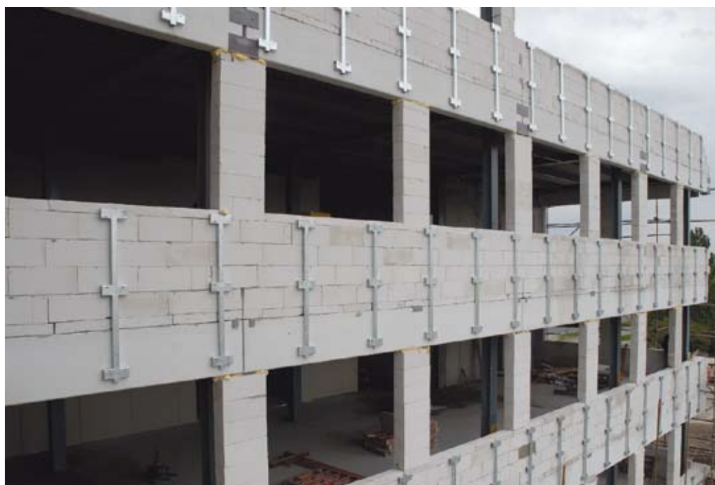
Obr. 1: Průběh vyzdívání obvodových stěn z pórobetonových tvárnic na zavěšené panely YTONG
