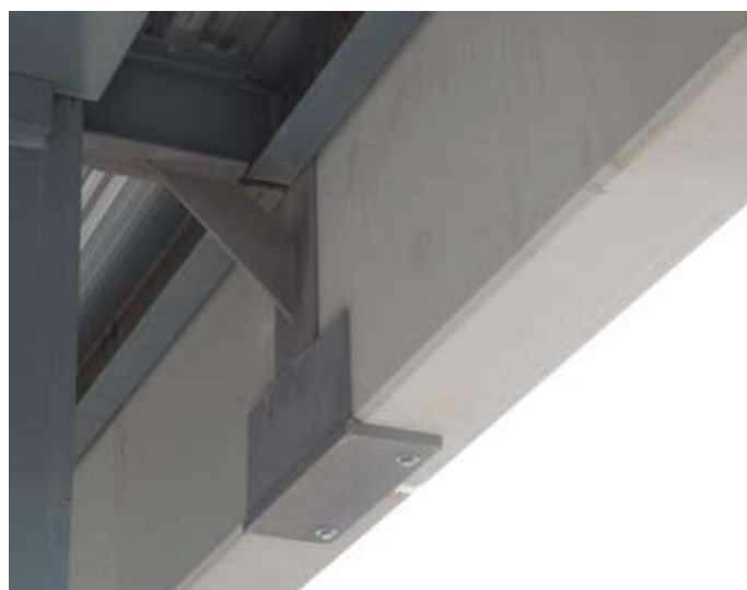
Obr. 2, 3: Detaily kotvení panelů k ocelovému skeletu stavby
