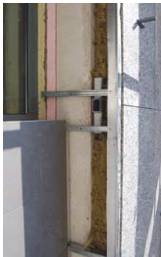
Obr. 4, 5: Skladba obvodového pláště s nadstandardními tepelněizolačními vlastnostmi
