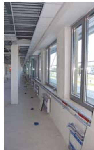
Obr. 6: Vnější plášť z interiéru budovy
