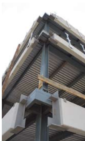
Obr. 2, 3: Detaily kotvení panelů k ocelovému skeletu stavby
