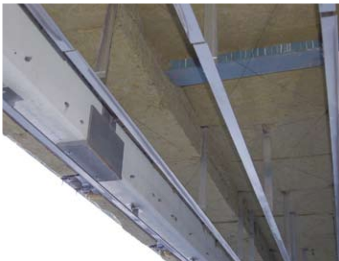
Obr. 4, 5: Skladba obvodového pláště s nadstandardními tepelněizolačními vlastnostmi
