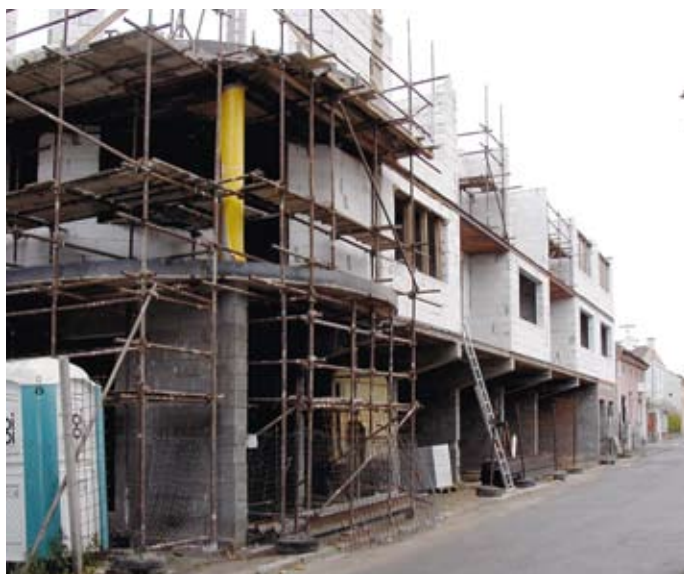
Spodní stavba a nárožní trakt je z železobetonového monolitu
