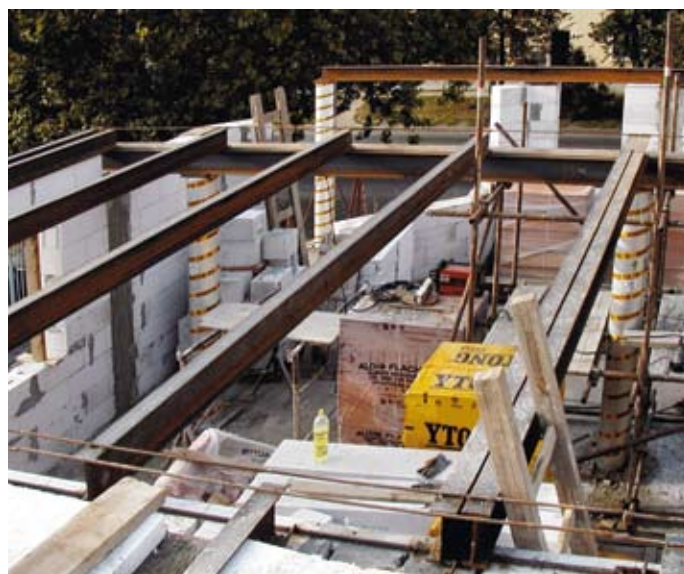
Stropní konstrukce z ocelových nosníků a stropních vložek Hurdis zůstala i po změně zdícího systému
