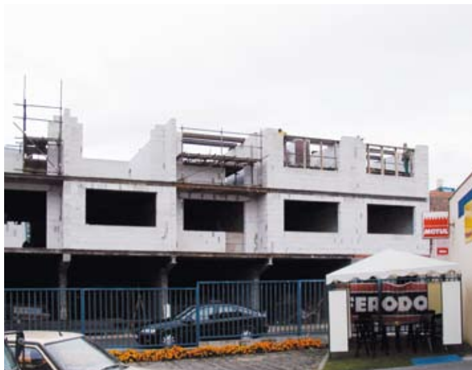
Na první pohled není patrný rozdíl mezi obvodovým zdivem z bílého Ytongu a příčnými stěnami z také bílých vápenopískových kvádrů
