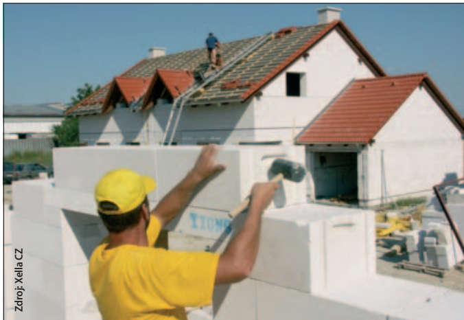
Zdroj: Xella CZ Moderní energeticky úsporné domy vyžadují absolutní přesnost zdění s tolerancí v řádu milimetrů. Právě nízká pracnost a vysoká přesnost pórabetonu YTONG jsou klíčem k nízkoenergetickým stavbám bez významného navýšení ceny.
