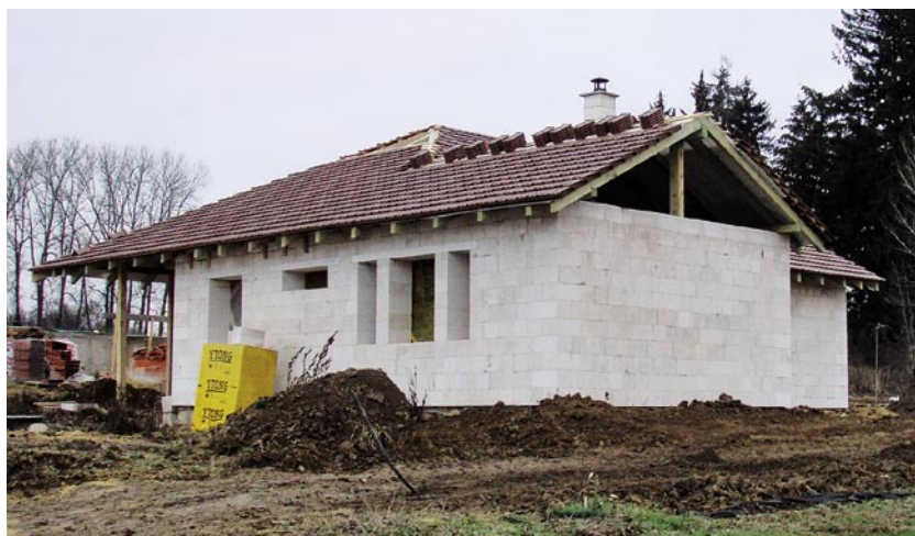
Bílá barva hrubé stavby naznačuje vysoký izolační standard domu. Ani sousedé ale nejspíš netuší, že se jedná o nízkoenergetický dům s třetinovou spotřebou tepla na vytápění. Z obvodových stěn YTONG LAMBDA bez zateplení.
