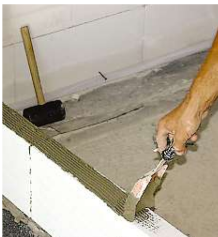
Stavba příčky s úsporou malty
