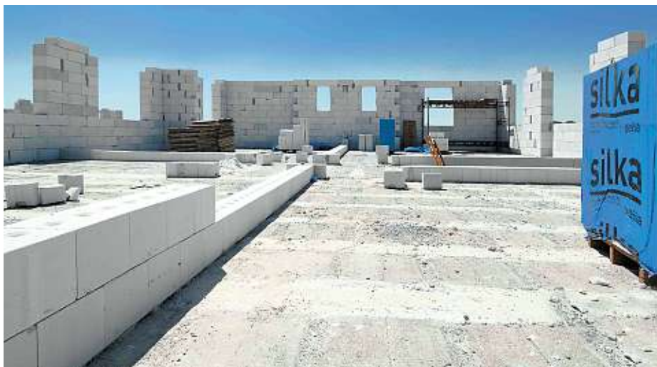
Vlastnosti materiálu dovolují optimální využití i pro nosné vnitřní stěny vícepodlažních budov
