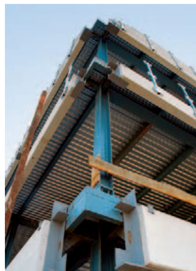
Detaily kotvení panelů k ocelovému skeletu stavby
