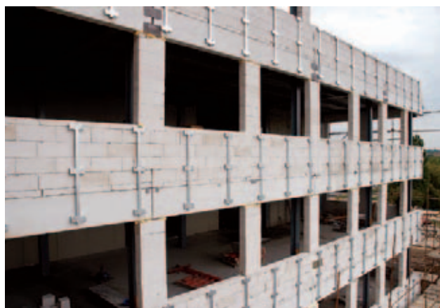
Průběh vyzdívky obvodových stěn z pórobetonových tvárnic YTONG na zavěšené panely HEBEL
