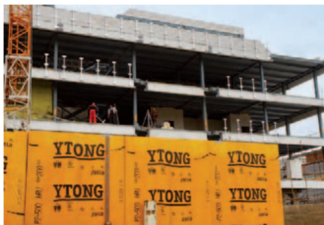
Průběh vyzdívky obvodových stěn z pórobetonových tvárnic YTONG na zavěšené panely HEBEL
