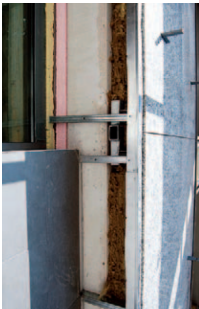
Skladba obvodového pláště zaručuje nadstandardní tepelně izolační vlastnosti
