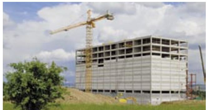
Tvárnice P1,8-300 jsou vhodné pro obvodové stěny skeletových vysokopodlažních domů.
