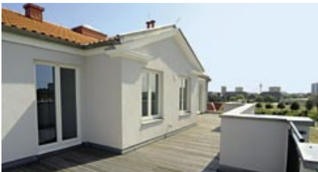
Nízká hmotnost tvárnic představuje minimální zatížení pro nástavby a přístavby starších domů.
