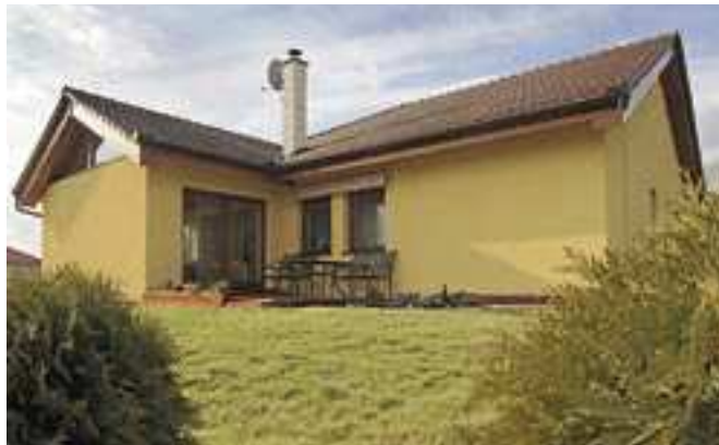
Nízkoenergetické domy se pomalu stávají masovou záležitostí a jejich podoba se blíží domům konvenčním. Nízkoenergetický dům v Černé hoře vděčí za svůj úsporný režim obvodovým stěnám Ytong Lambda tloušťky 500 mm bez zateplení.
