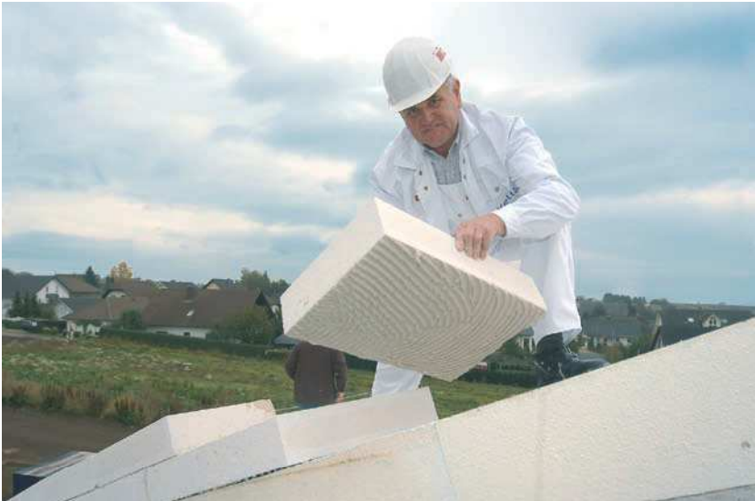
Masivní střešní konstrukce z panelů Ytong a izolace Ytong Multipor s dokonalými izolačními parametry a optimální tepelnou akumulací
