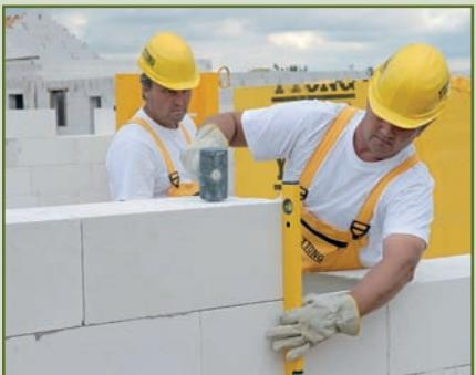
**Snadné řezání** a opracovatelnost póróbetonu umožňuje dokonalé vyzdění i ve stísněných prostorech například pod střechou. Atycké formáty je možné jednoduše příříznout
