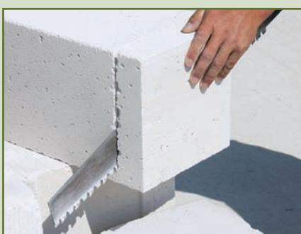
a není tak potřeba objednávat různé speciální tvarovky a rozměrové varianty. Na řezání tvárnic je vhodná ruční pila na póróbeton nebo stačí obyčejná pilka na dřevo. Dochází tak k minimálnímu odpadu materiálu na stavbě, což představuje další časové i finanční úspory.
