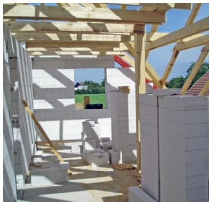
Dokonalým materiálem pro realizace střešních nástaveb je masivní póróbetonové zdivo Ytong, které vám garantuje jedinečné mikroklima i pod rozpálenou střechou a zároveň pro stávající stavbu představuje minimální konstrukční zatížení. Výrobce Ytongu přitom letos na trh uvedl svou další novinku, tvárnice Ytong třídy P1,8–300, které jsou pro střešní nástavby přímo určené. Jde o bezkonkurenčně nejlehčí masivní zdící materiál na našem trhu. I přes neobyčejně nízkou
