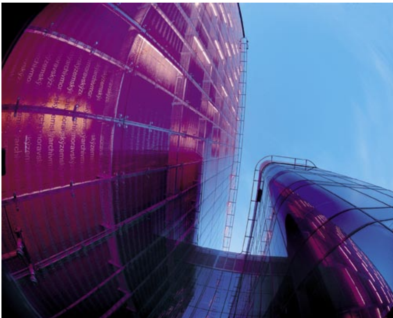
Skleněná fasáda s potiskem a společně s barvou a hrou světél vytvářejí jednotný scénický celek.
