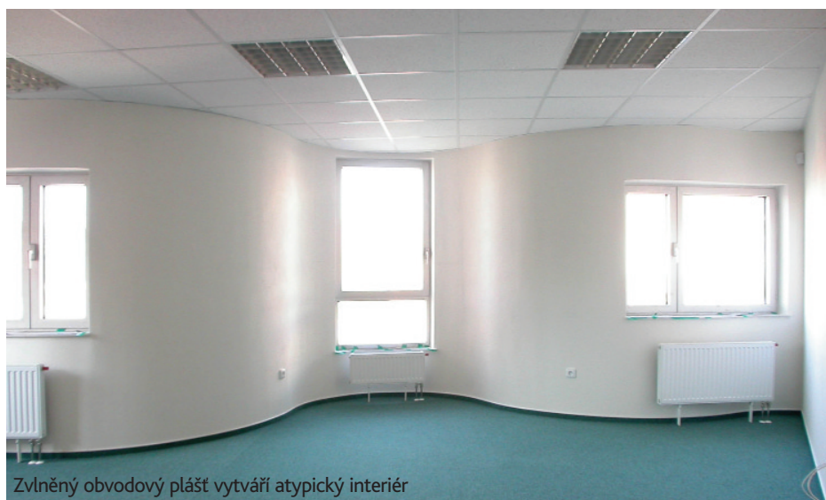
Vlnovky byly řezány na míru na stavbě podle šablon
