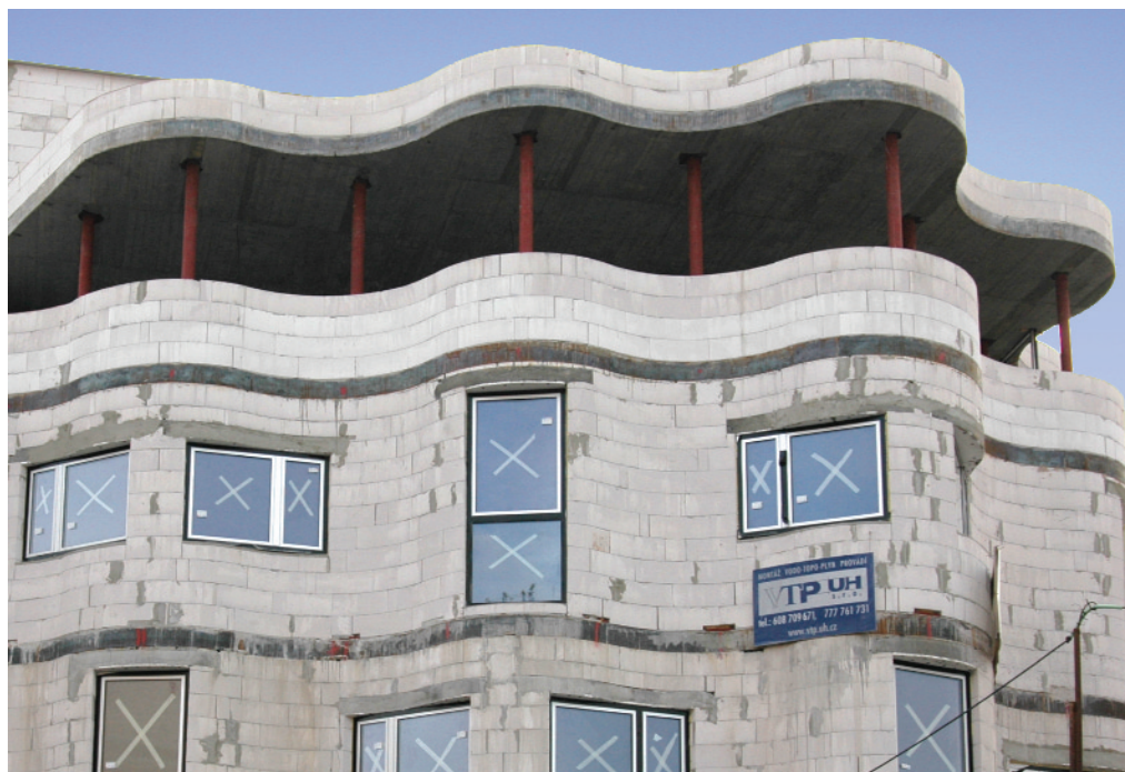
Vlnovky byly řezány na míru na stavbě podle šablon
